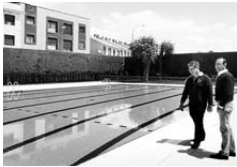
El edil del área y el alcalde revisaron la obra antes de la apertura./ENE
